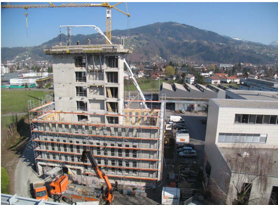
Foto: Cree Die Ansicht des LCT ONE am 3. Tag der Montage
