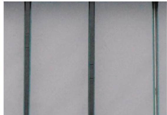
Entwicklung der Kollektorfassade – Verwendung von Profilglas
