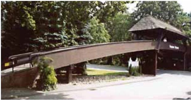
Bild 6b Fußgänger- und Radwegbrücke Walsrode (1972)
