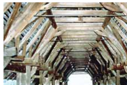
Bild 3c Ehem. Straßenbrücke Wangen (1550)
