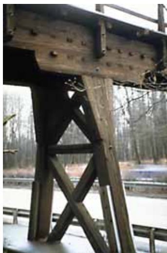
Bild 2 Ehem. Fußgängerbrücke über die BAB 8 bei Pforzheim-West
