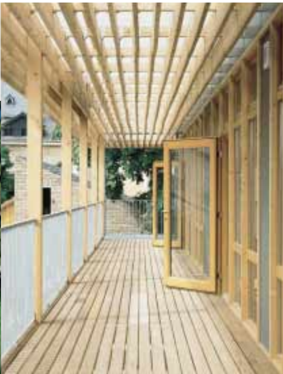
Abb. 42: Frei vor der Fassade stehender Balkon in einem Kindergarten
