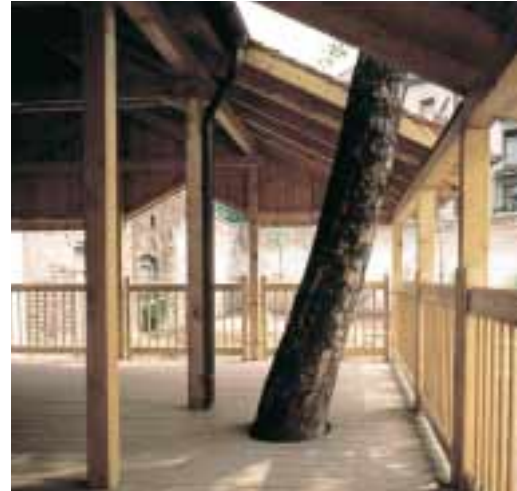
Abb. 34: Aufgeständerte Terrasse
