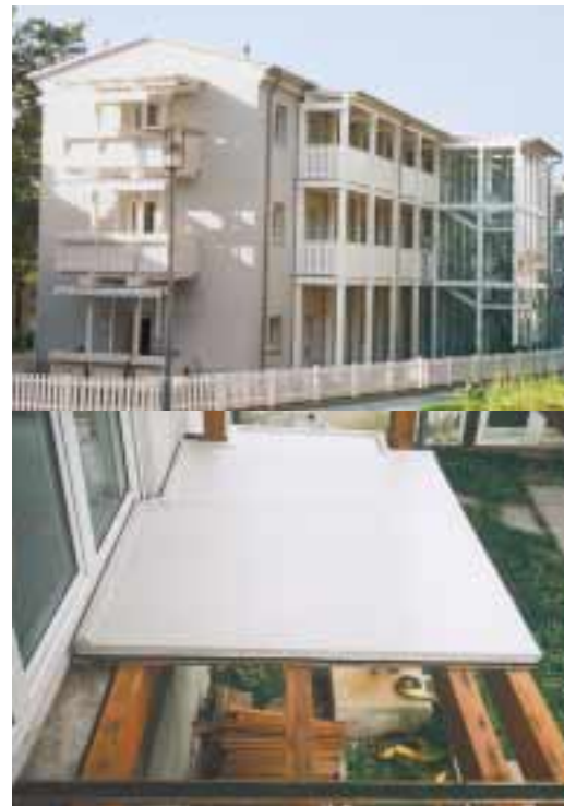
Abb. 44, 45: Balkonanlage mit Balkodur® Platten als tragende Platte
