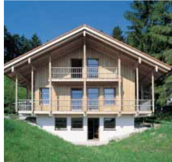
Abb. 41: Angehängter Balkon
