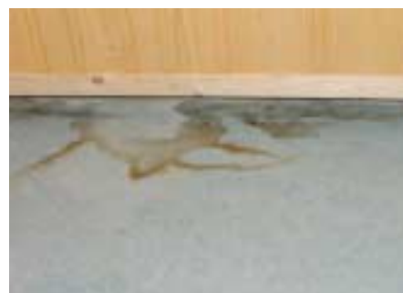
Abb. 3.3.3: Wasserfleck durch Tauwasserbildung hinter einer Vorsatzschale.
