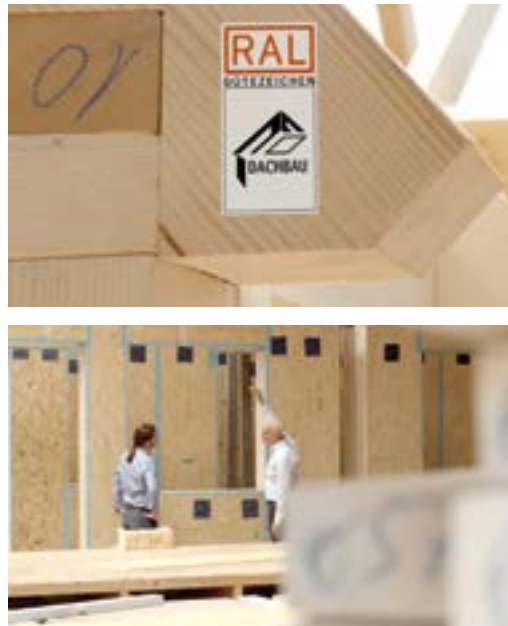
Abb. 17a und b: Kennzeichnung eines Bauteils mittels Aufkleber
