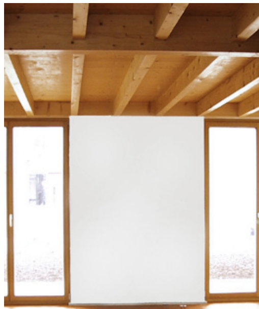
Abb. 5.09: Sichtbare Dachbalken
