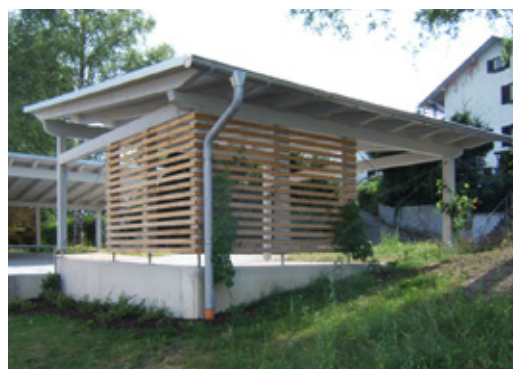
Abb. 6.03: Carport mit Stützen
