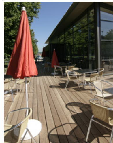
Abb. 6.02: Terrasse aus dauerhaften Hölzern, z.B. Eiche; Sportheim Markbronn
