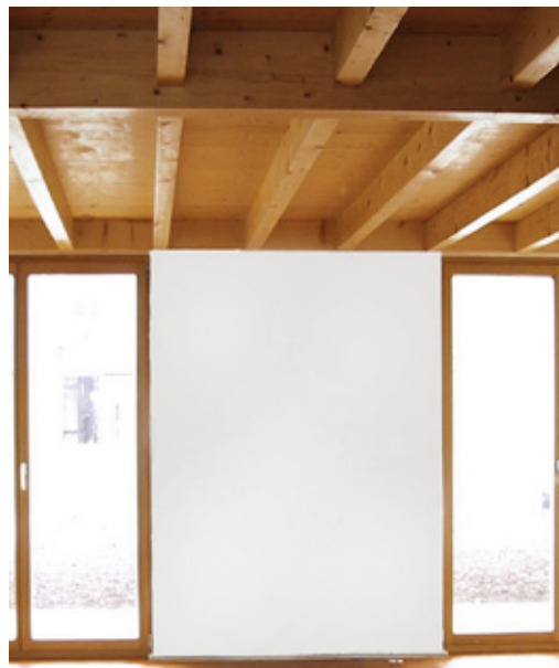
Abb. 5.09: Sichtbare Dachbalken
