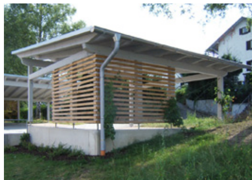
Abb. 6.03: Carport mit Stützen
