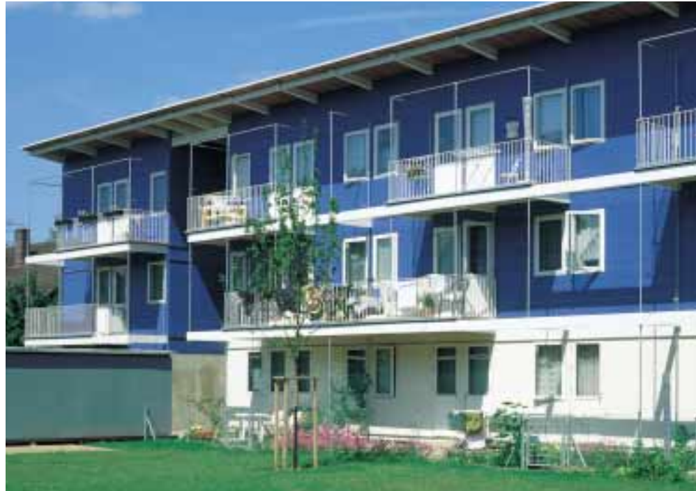
Abb. 37: Auskragende Balkonanlage an einem Mehrfamilienhaus
