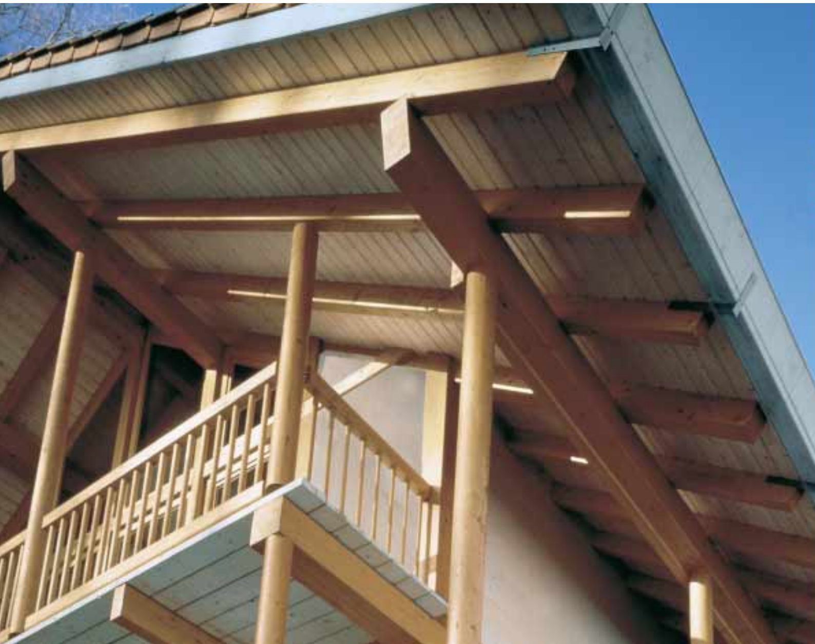
Abb. 36: Aufgeständerter Balkon auf hölzernen Rundstützen
