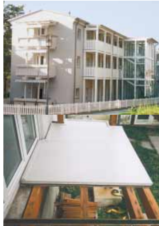
Abb. 44, 45: Balkonanlage mit Balkodur® Platten als tragende Platte
