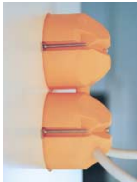
Abb. 3.1.12: Luftdichte Hohlwanddose.
